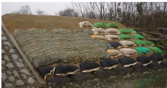
写真-1 施工直後法面状況
