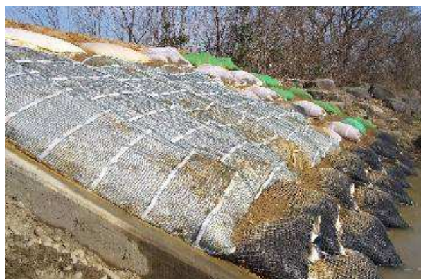
写真-4 植生方法②・④・⑤設置
