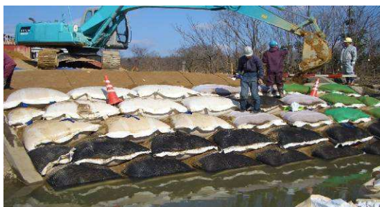
写真－1 袋体積上状況
