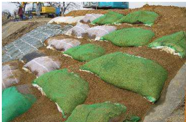
写真-3 植生方法①・③設置
