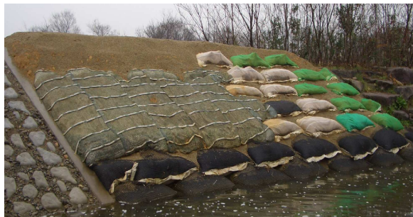
写真－４ 法面植生施工直後
