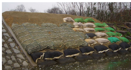
写真－2 施工完了状況
