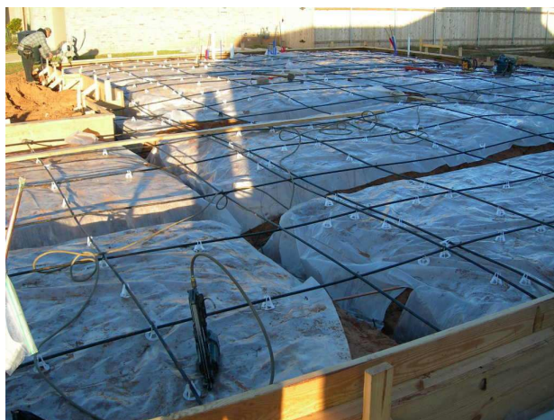
写真-1 スラブオングラウンド (リブ基礎)
