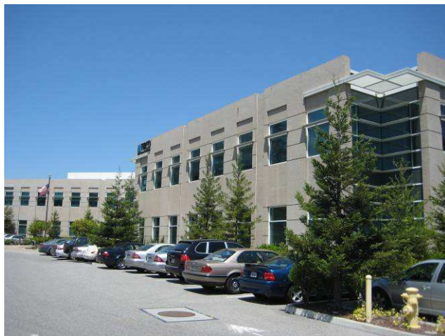
写真-11 ティルトアップオフィス建築例
