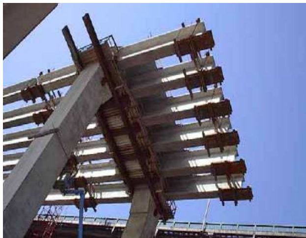
写真－15 ストロングバック利用のスプライス
