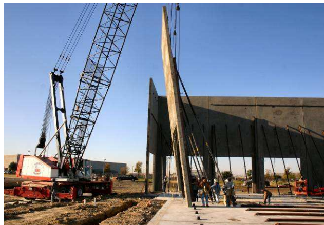
写真-10 ティルトアップパネル吊り上げ状況 ( http://www.constructionphotographs.com/ )
