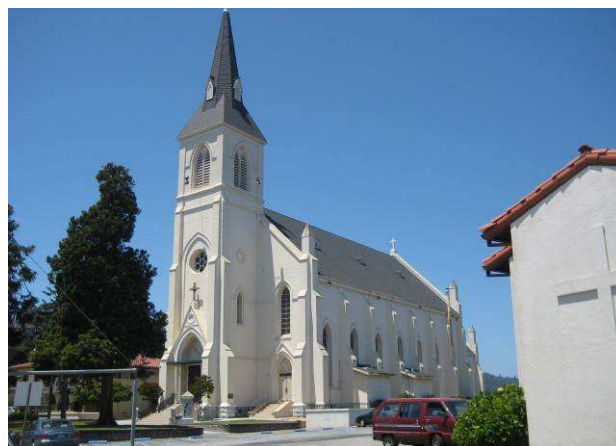
写真-14 ホーリークロス教会 PC耐震補強
