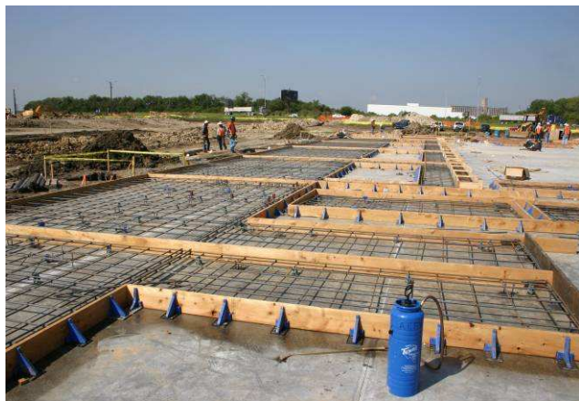
写真-9 ティルトアップパネル打設前 ( http://www.constructionphotographs.com/ )
