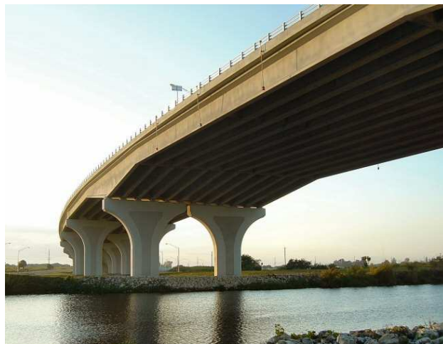
写真－16 3径間スプライスガーダー橋
