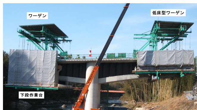
写真－1 ワーゲンと低床型ワーゲンの併用施工状況
