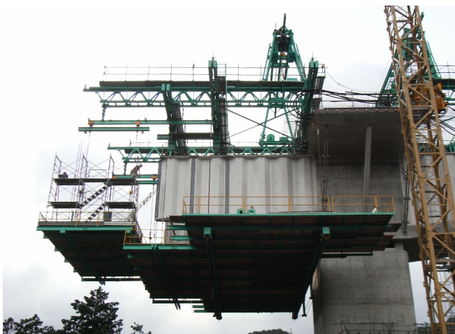
写真-2 先行張り出し架設機の組立状況
