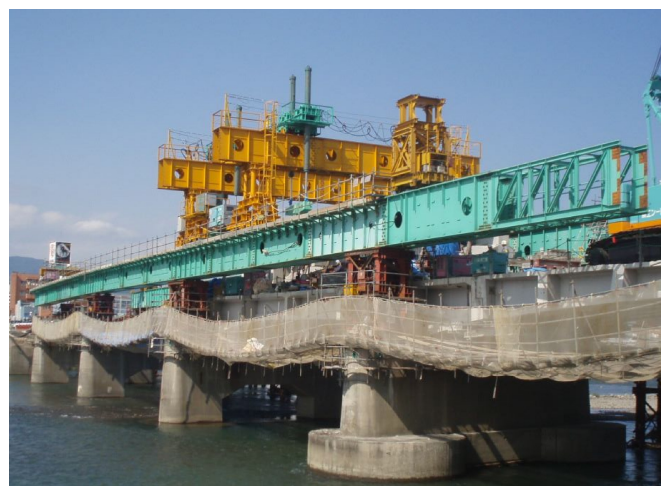
写真-3 橋桁一括撤去架設機全景
