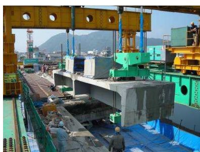
④-1 主桁吊上げ状況
