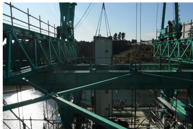
写真－9 架設機後方から架設状況
