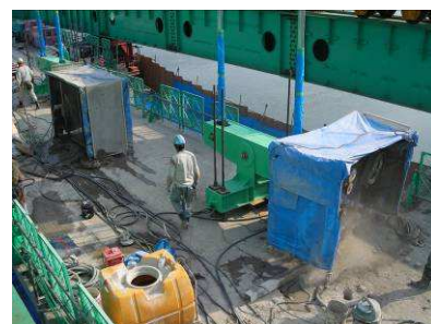
③ 桁端部・横桁の切断状況
