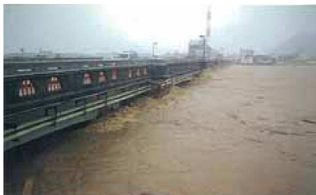
写真－15 出水時の旧安賀多橋の状況
