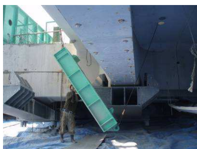
②-1 桁下吊り金具振込み
