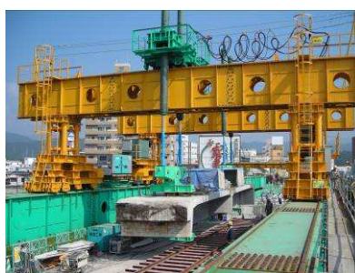
④-2 主桁運搬(走行)状況
