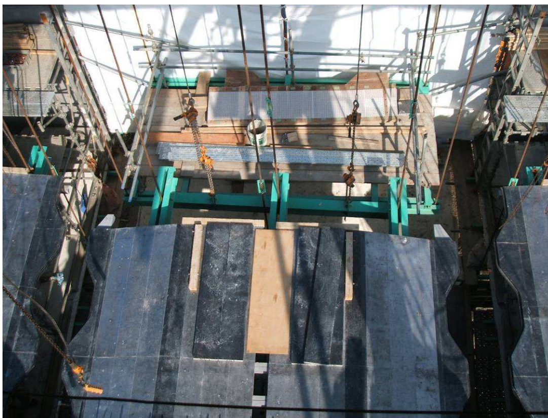
写真－４ 低床型ワーゲンの前方上部作業台施工状況
