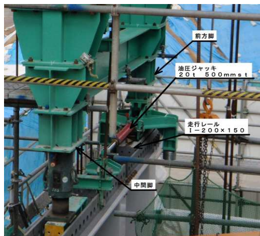
写真-10 移動装置および前方レール
