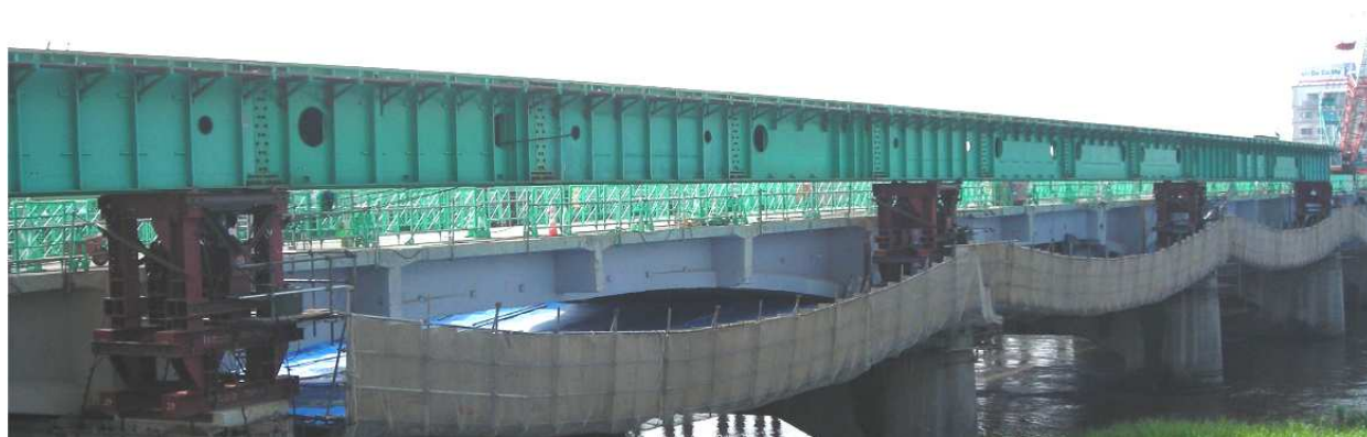
写真-18 走行路ガーダーの全景
