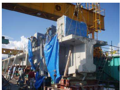
⑦主桁小割切断状況
