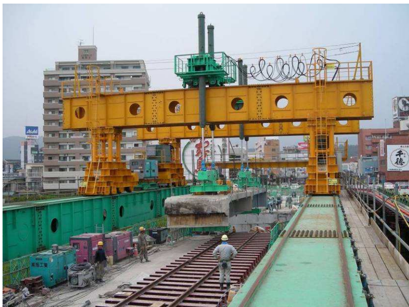
写真－17 橋形クレーンによる主桁運搬状況
