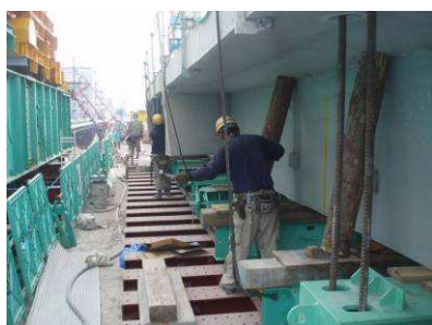
⑥ 転倒防止措置状況
