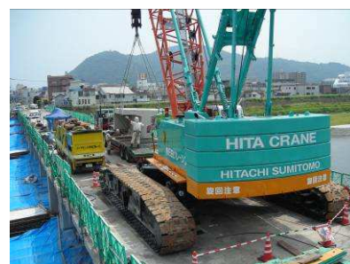
⑧ 主桁搬出状況
