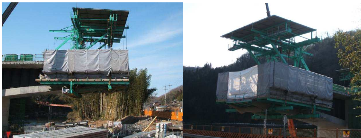
写真-2 低床型ワーゲンの施工状況
