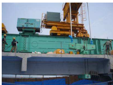
②-3 桁吊り金具取付完了
