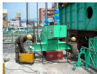
②-2 ゲビンデ鋼棒緊張状況
