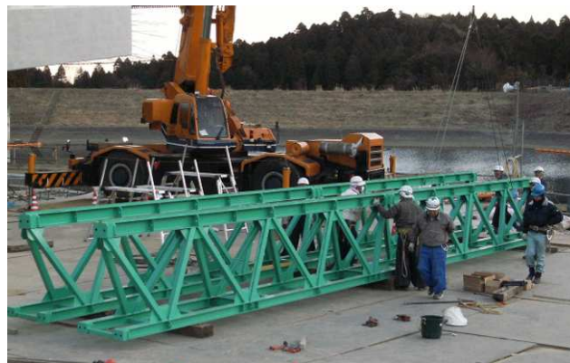
写真－7 ランウェイの組立状況
