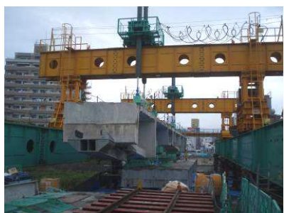
④-2 主桁運搬(走行)状況
