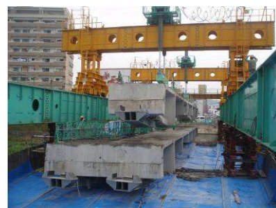
④-1 主桁吊上げ状況
