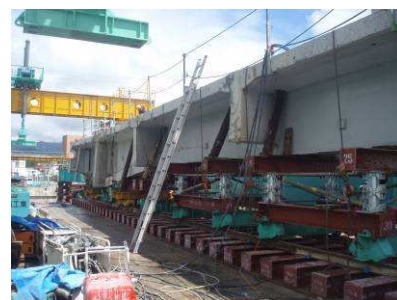
⑥転倒防止措置完了
