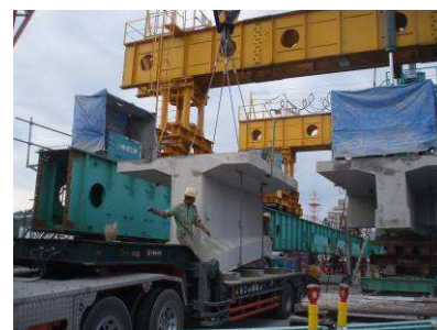
⑨主桁搬出状況
