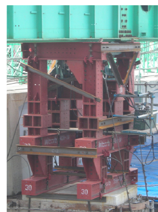
写真-19 ベントの設置状況
