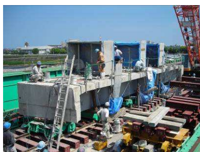
⑦ 主桁小割切断状況
