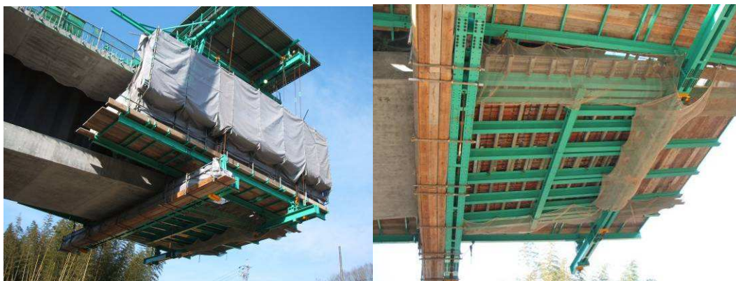
写真－３ 低床型ワーゲンの下部作業台施工状況
