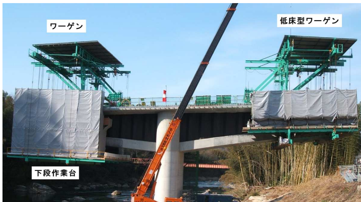
写真－1 従来ワーゲンと低床型ワーゲンの併用施工状況
