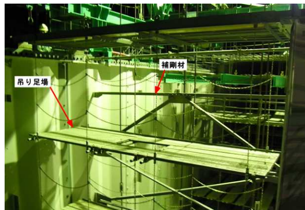
写真-13 吊り足場での使用状況
