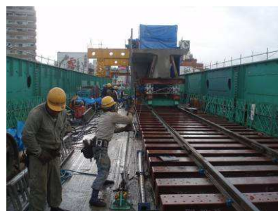
⑧主桁引出し状況(ホルダー×2)
