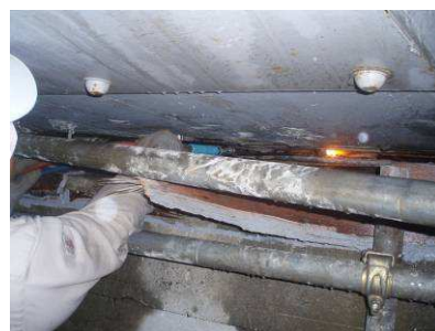
③-2 アンカー切断状況(φ 32 × 4)
