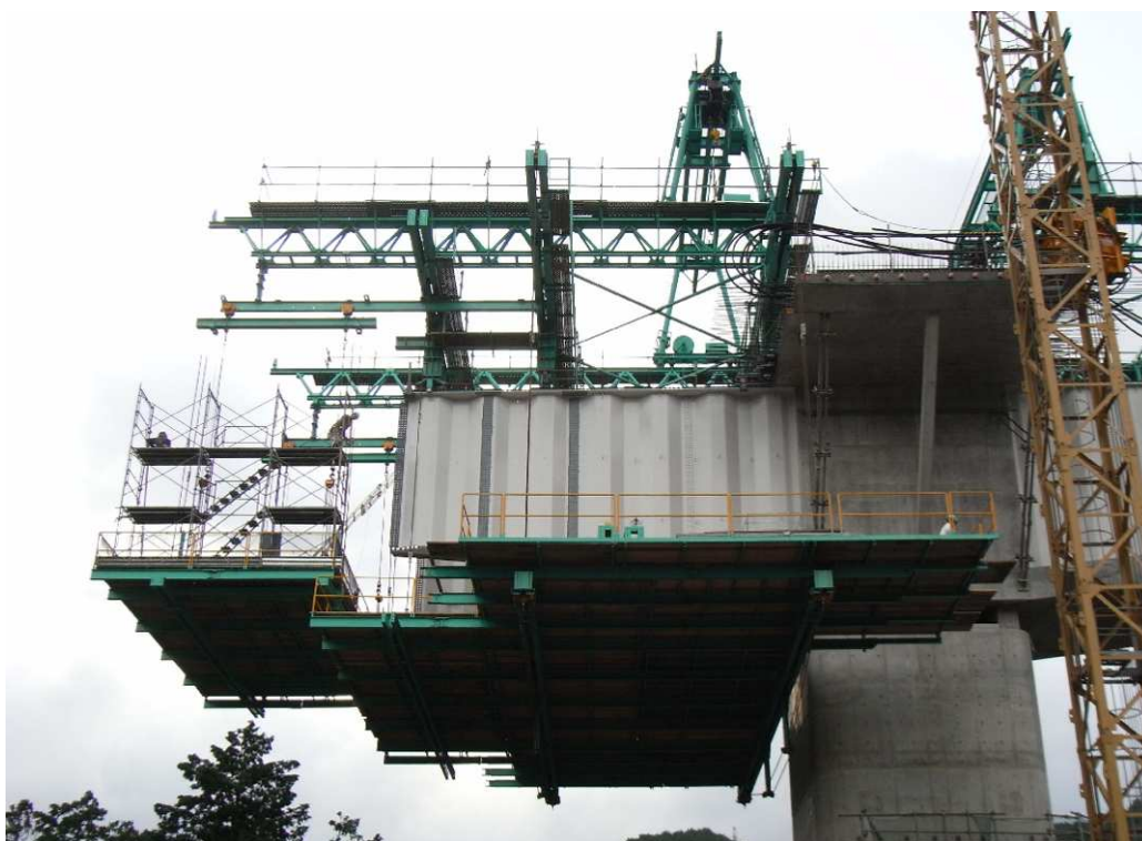
写真-5 先行張り出し架設機の組立状況
