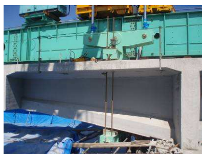
②-1 桁吊り金具取付完了
