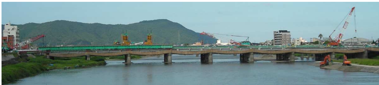
写真－16 安賀多橋撤去工事全景
