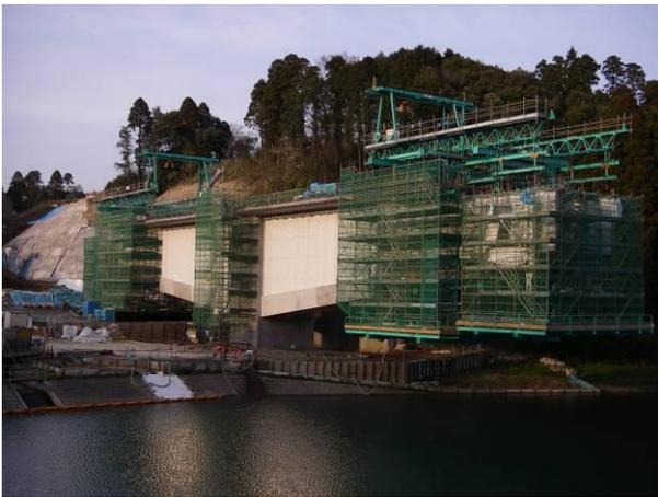
写真-2 上部工施工状況
