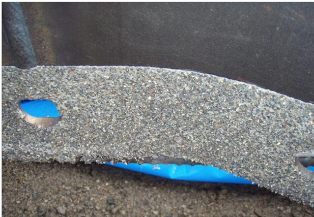
写真-2 接合面の珪砂吹付状況
