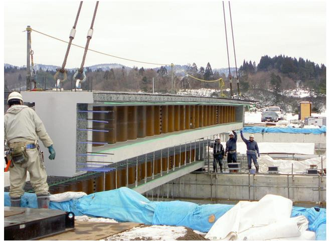
写真-3 主桁架設状況
