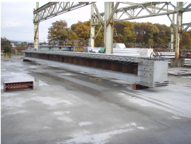
写真-1 主桁仮置き状況
