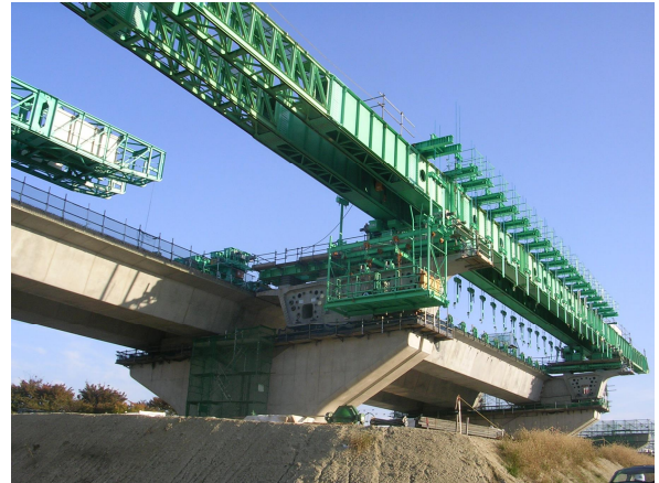
写真-2 ハンガータイプ架設機
