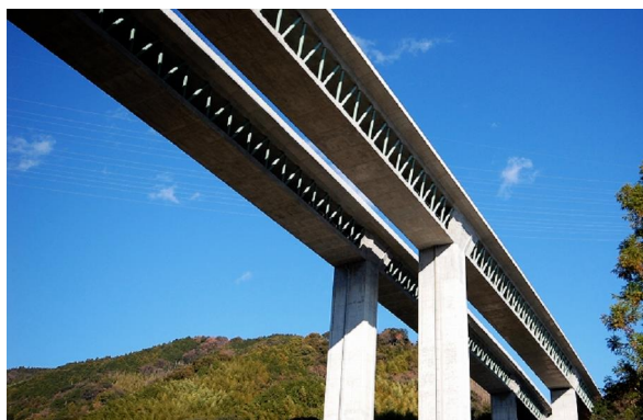
写真-1 完成状況（巴川橋）
