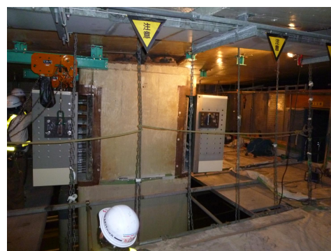
写真-2 ブラケット設置状況
