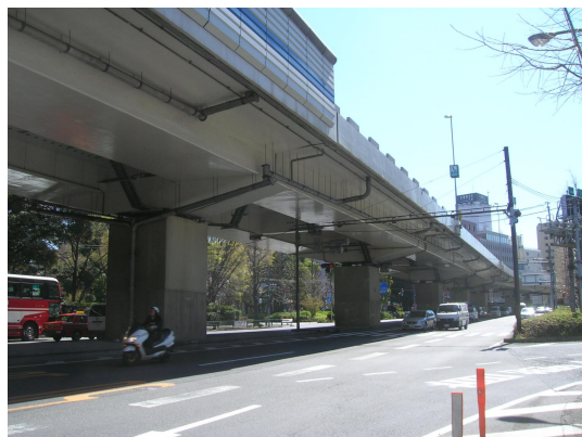
写真-1 施工区間 (例)
