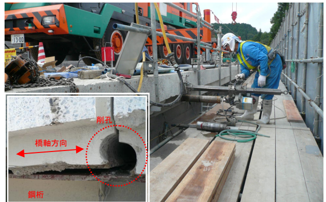
写真-4 削孔状況
