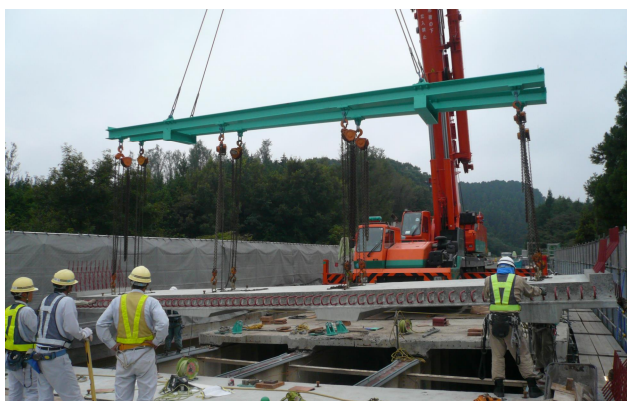
写真-1 架設状況
