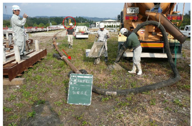
写真-5 圧送試験状況
