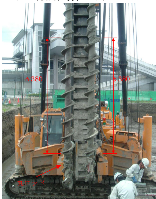
写真-2 オーガスクリュー先端
