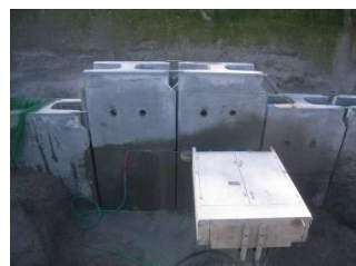
写真-2 切断状況
