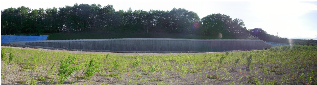
写真-1 完成写真
