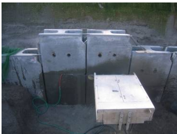
写真-2 切断状況
