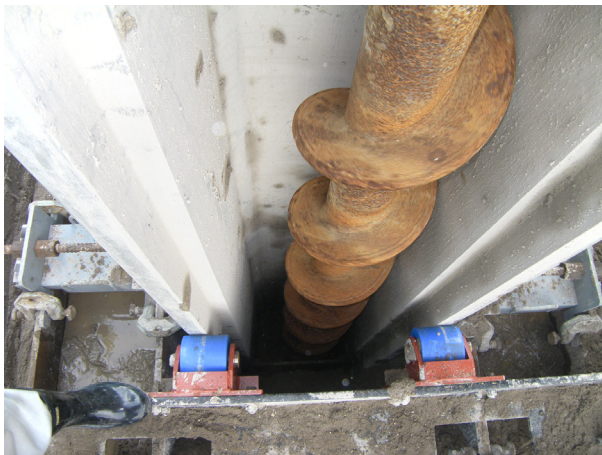
写真-6 H740 タイプにスクリュー径 \phi 280
