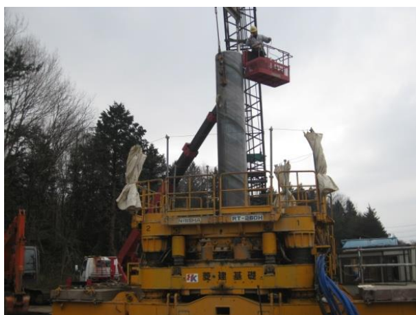
写真-3 孔内傾斜計測定状況
