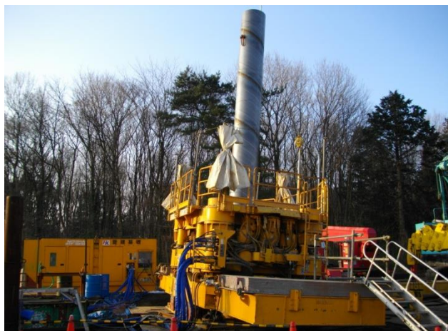
写真-1 斜杭施工状況
