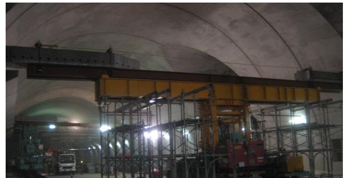
写真-2 吸気口PC版架設状況
