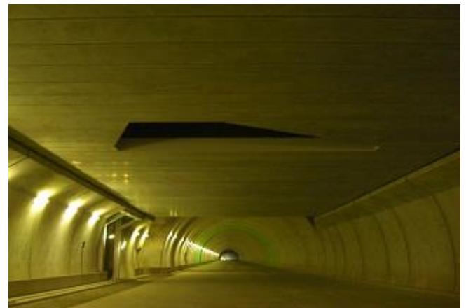
写真-3 天井版全景
