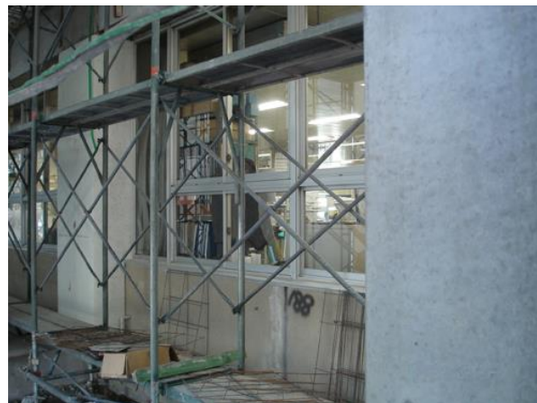
写真-2 施工中の建物の使用状況
