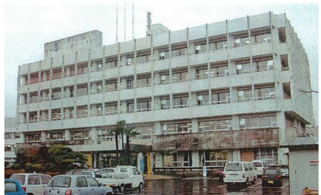
写真-1 建物南面外観
