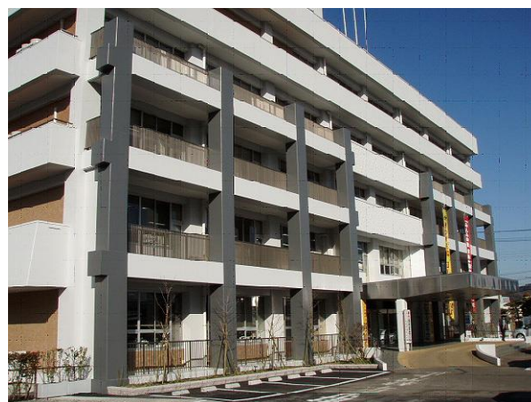
写真-3 補強・改修後の建物南面外観
