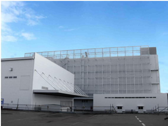
写真-1 建物外観
