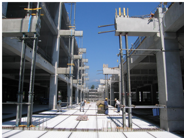
写真-2 後施工工区
