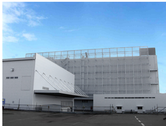
写真-1 建物外観
