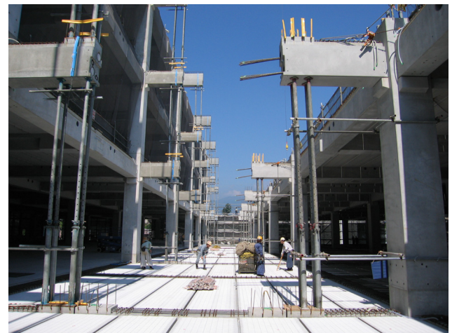
写真-2 後施工工区
