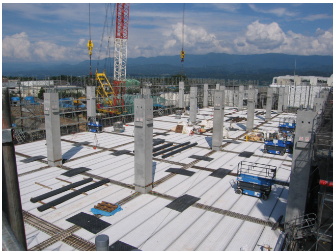
写真-3 PCa 柱建て方状況
