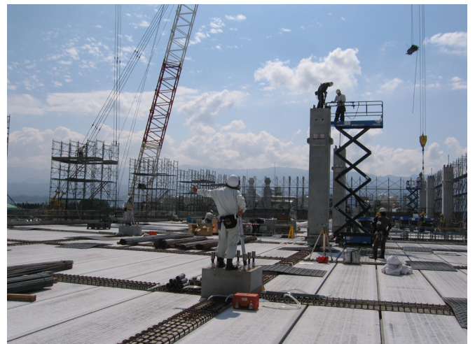
写真-4 PCa 柱建て方精度管理状況
