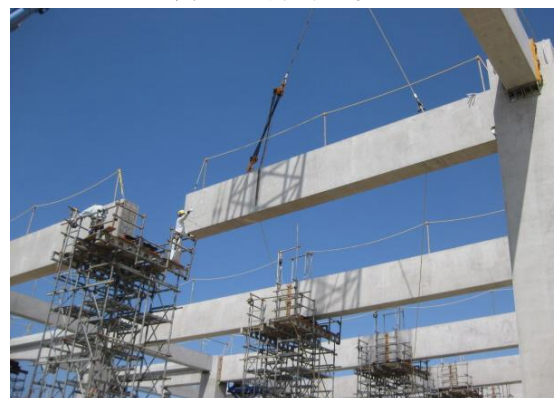
写真-4 梁部材架設状況
