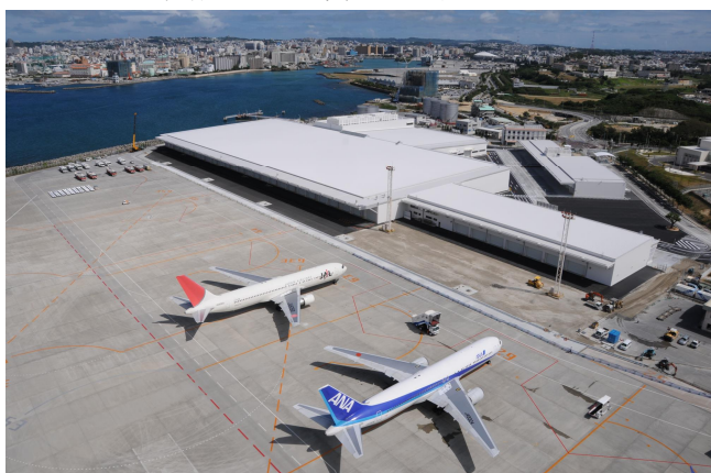
写真-1 完成写真
