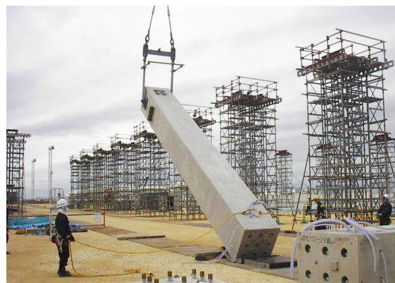
写真-3 柱部材架設状況
