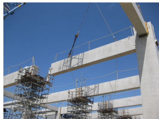
写真-10 梁部材架設状況
