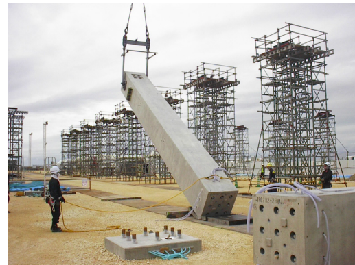
写真-8 柱架設状況
