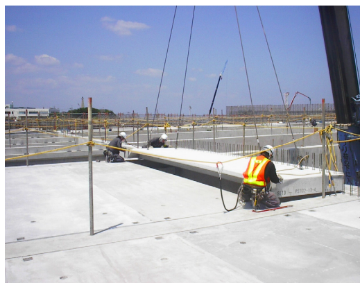
写真-16 DT 版架設状況
