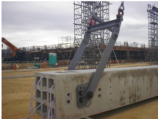
写真-7 柱吊り治具
