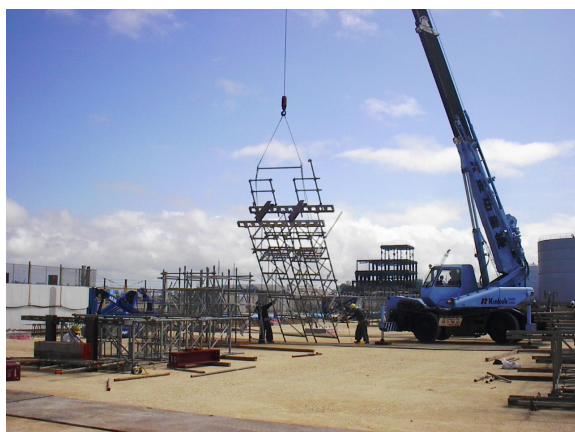
写真-5 ベント組立状況
