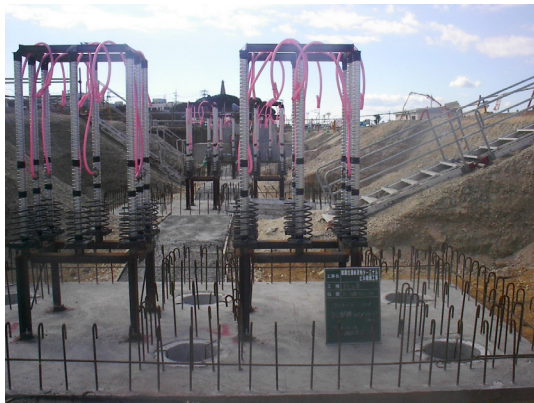
写真-3 アンカーセット状況
