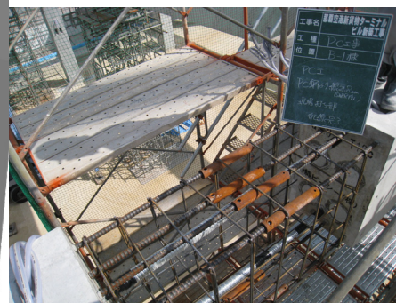
写真-2 接合部配線状況
