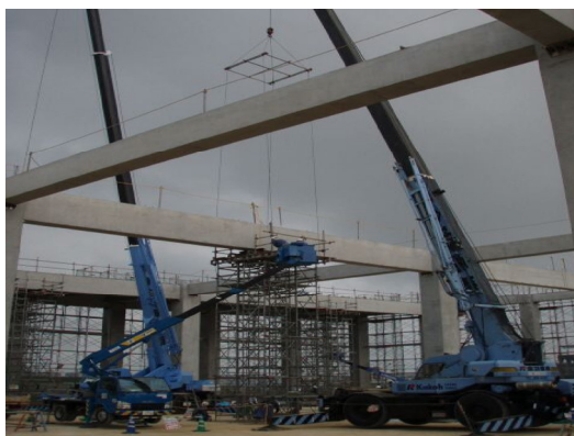
写真-13 ベント解体状況
