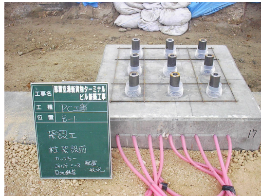
写真-4 柱脚墨出し状況
