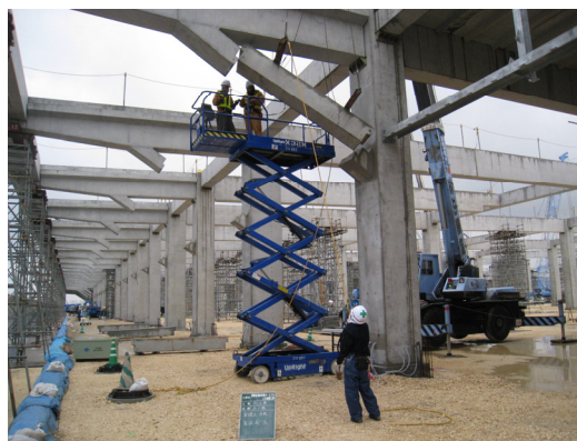
写真-14 PV 版架設状況
