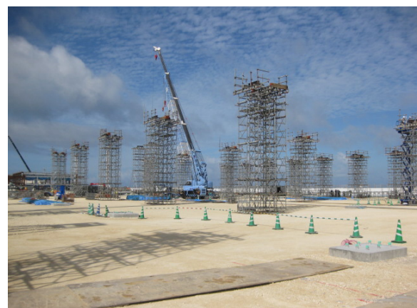
写真-6 ベント組立状況(全景)
