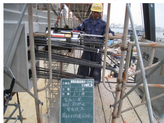
写真-12 梁部材緊張状況
