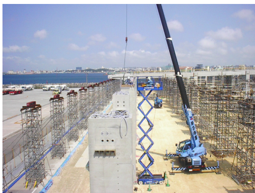
写真-9 PC 鋼棒緊張状況
