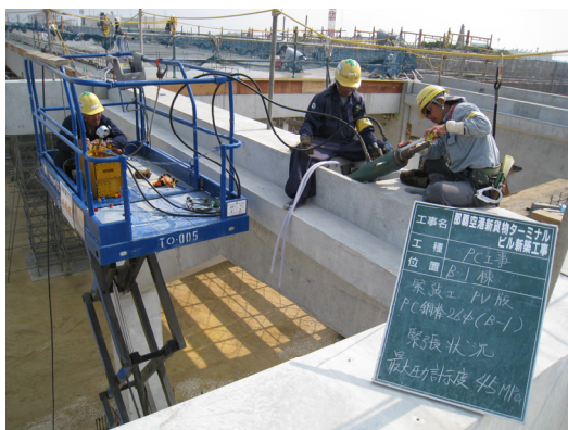
写真-15 PC 鋼棒緊張状況
