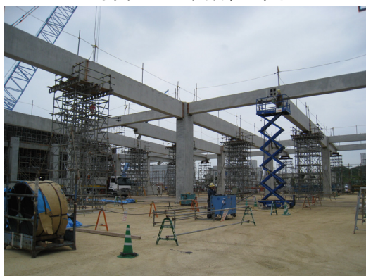
写真-11 PC 鋼より線挿入状況
