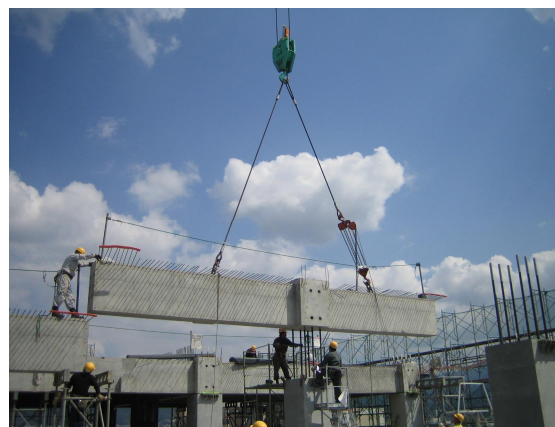
写真-3 桁梁架設状況
