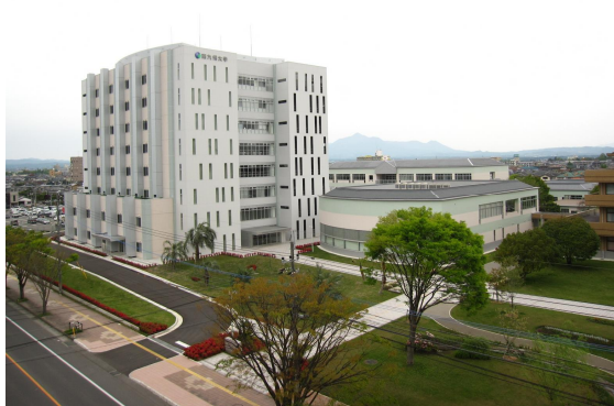
写真-1 建物外観
