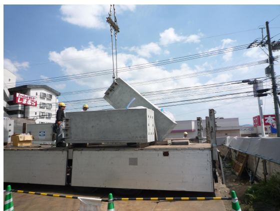
写真-2 柱部材建起し状況
