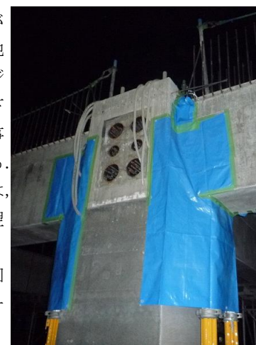
写真-4 保温養生状況
