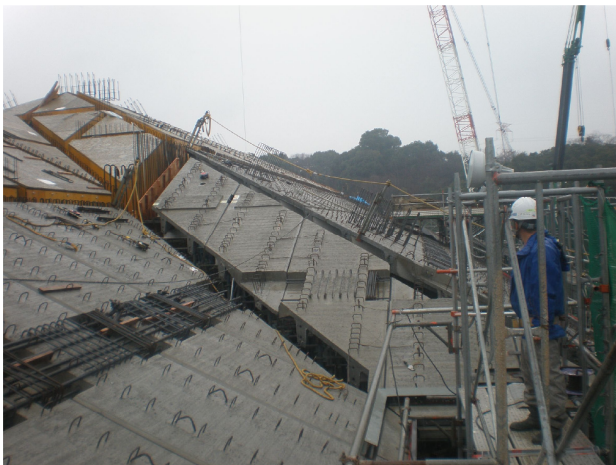
写真-5 PCa版施工状況
