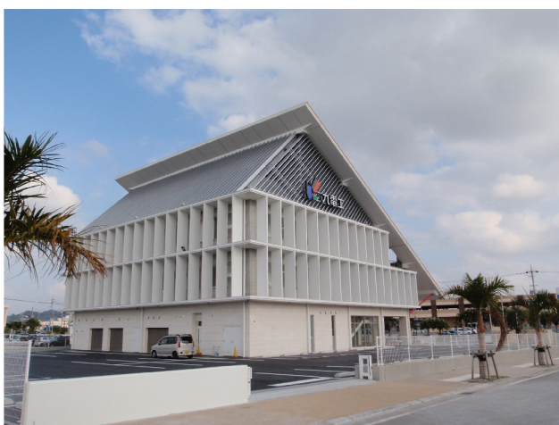
写真-9 建物外観（西面）
