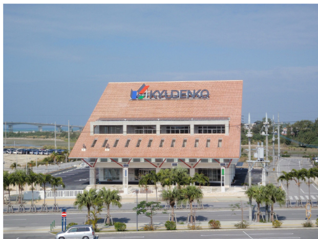
写真-7 建物外観（南面）
