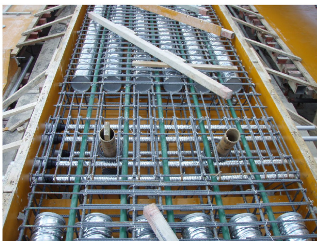
写真-12 PCa 部材配筋状況
