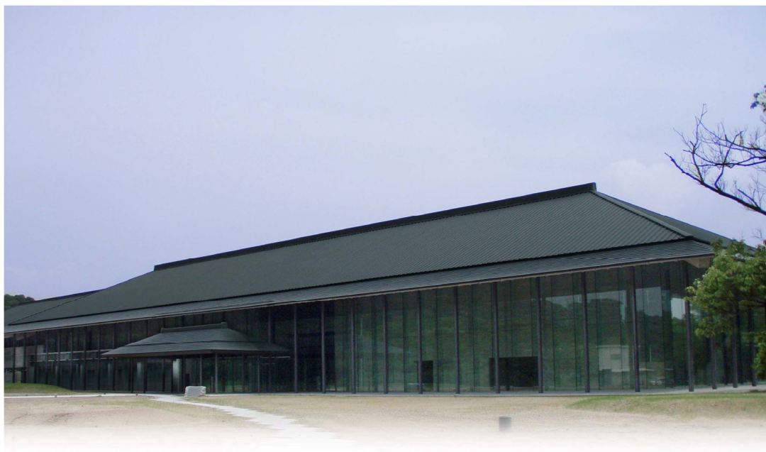
写真-1 建物外観
