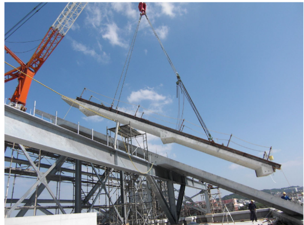
写真-14 架設状況
