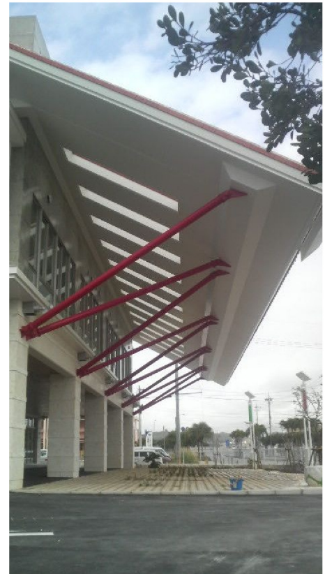
写真-10 方杖底部
