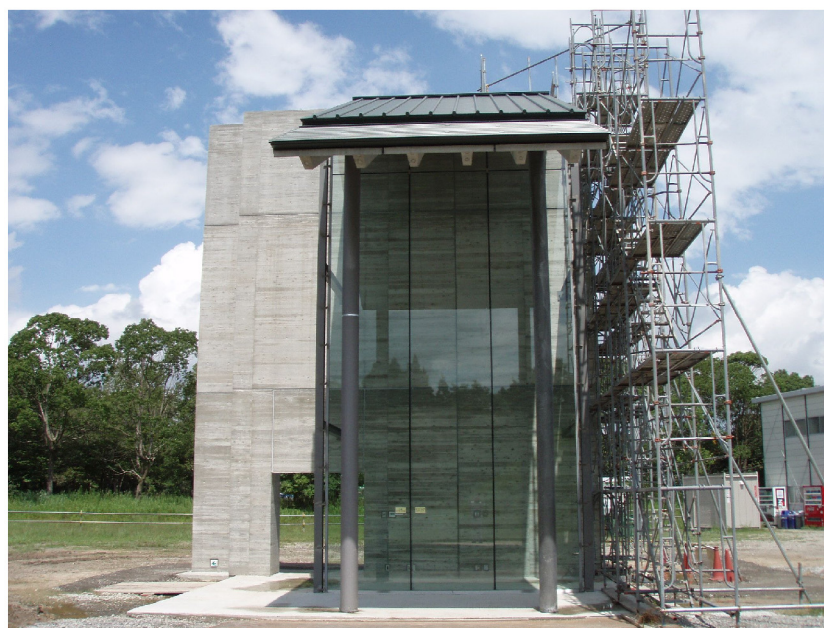
写真-4 モックアップ全景
