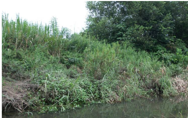
写真-3 施工後状況
