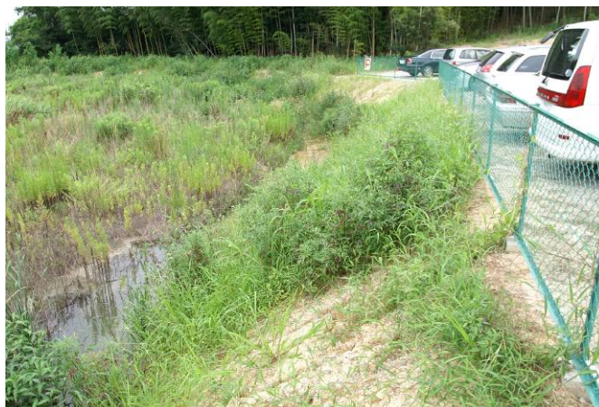
写真-1 施工後状況
