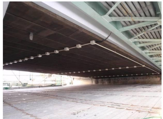
写真-4 チタン溶射施工完了
