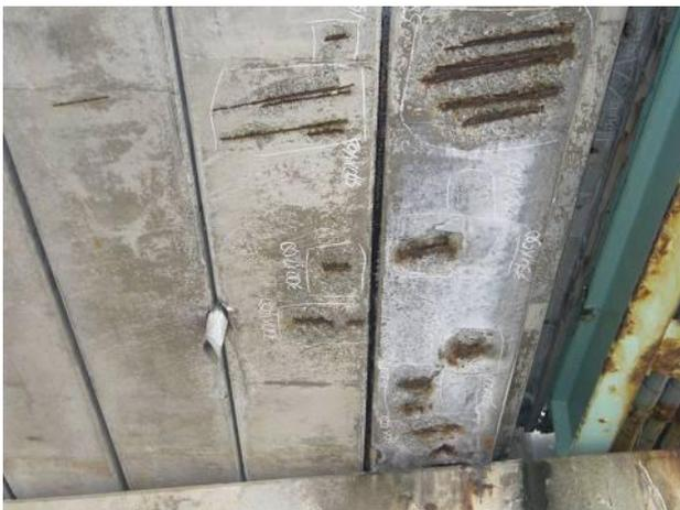
写真-1 主桁下面劣化部(海側の耳桁)
