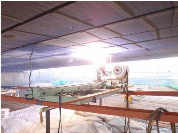
写真-2 チタン溶射状況(自動溶射装置)
