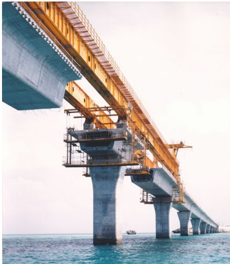
バランスドカンチレバー架設
