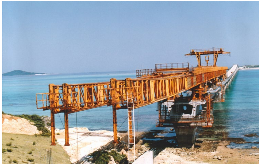
池間島側へ架設機の到達
