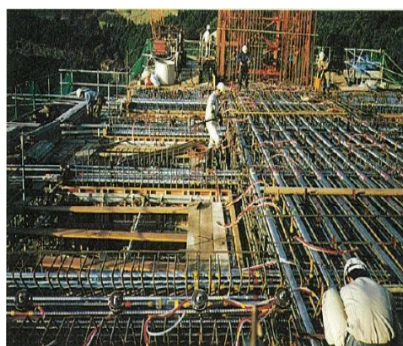
主塔受梁部・橋桁柱頭部施工
