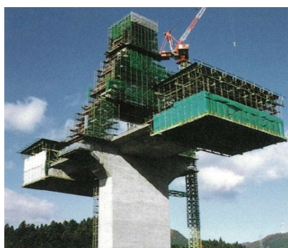
主塔施工、橋桁張出し架設
