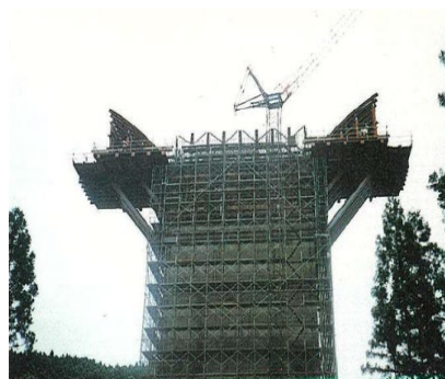
主塔受梁部 Bracket 支保工組立
