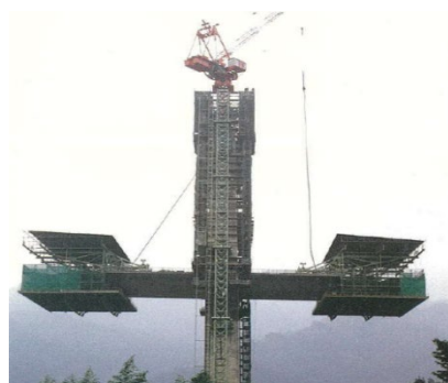
斜材ケーブル架設(全体)
