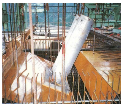
橋桁側斜材鋼管・ 定着部横桁型枠セット
