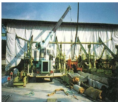
斜材ケーブル架設(橋面上)
