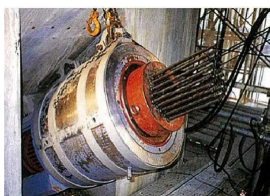
センターホールジャッキによる 一次緊張
