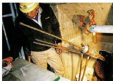
シングルストランドジャッキ による架設緊張
