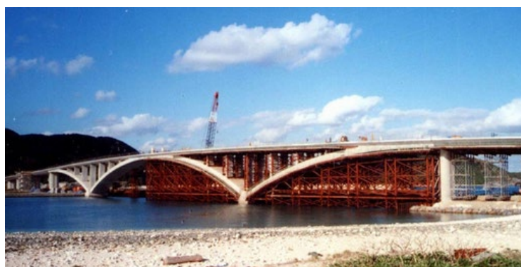
支保工による架設(P5系)
