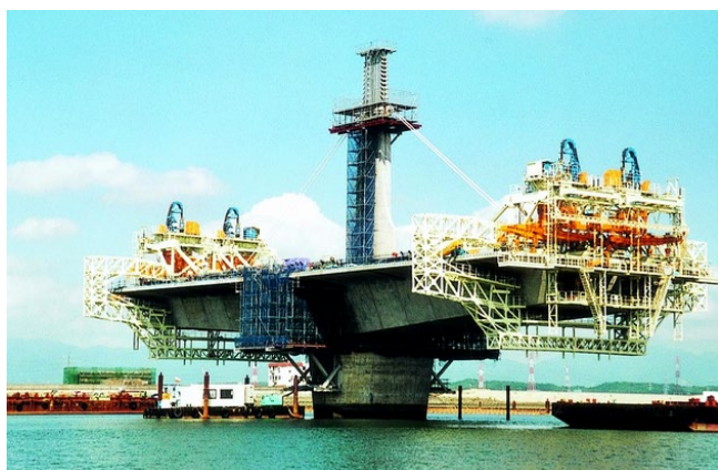
セグメントの架設装置
