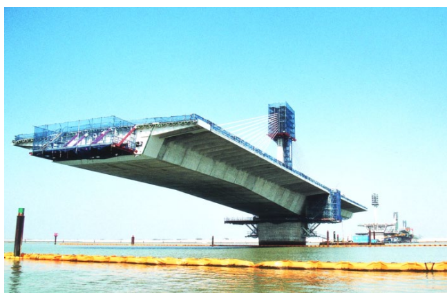
セグメントの架設終了
