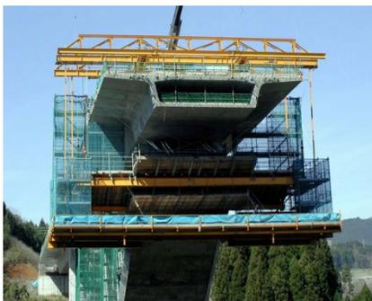
補剛桁の移動作業車
