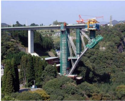
トラス工法による施工
