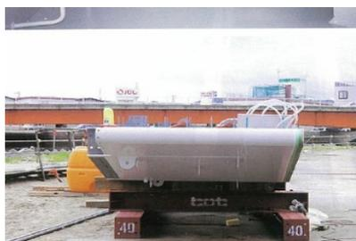
鋼コンクリート複合接合桁
