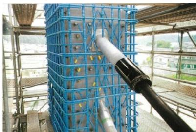
主塔鋼コンクリート複合構造
