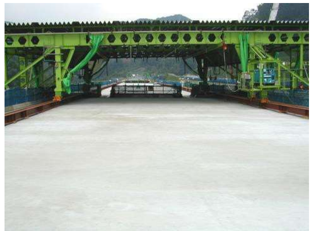
床版コンクリート打設後
