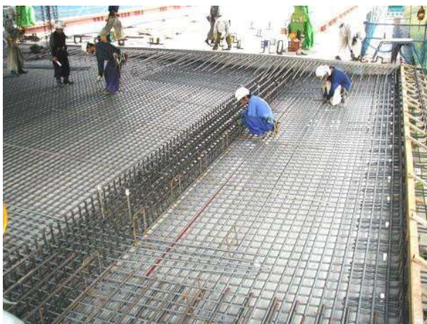
鋼板部分の鉄筋組立
