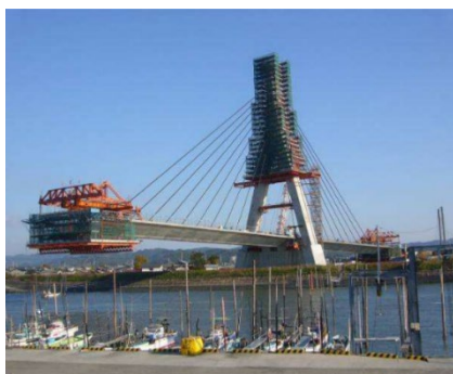
超大型ワゴン施工
