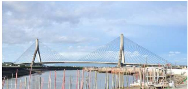
本橋は、1級河川矢部川を渡河する橋長517mのPC3径間連続斜張橋である。国内最大の支間長を有するPC斜張橋であり、曲線斜張橋であること、大深度のニューマチックケーソン基礎を採用しており、多くの技術的特徴を有する。
