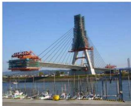
超大型移動作業車による施工
