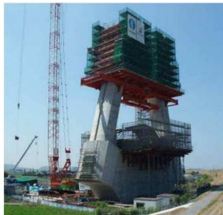
自己上昇型枠による主塔の施工
