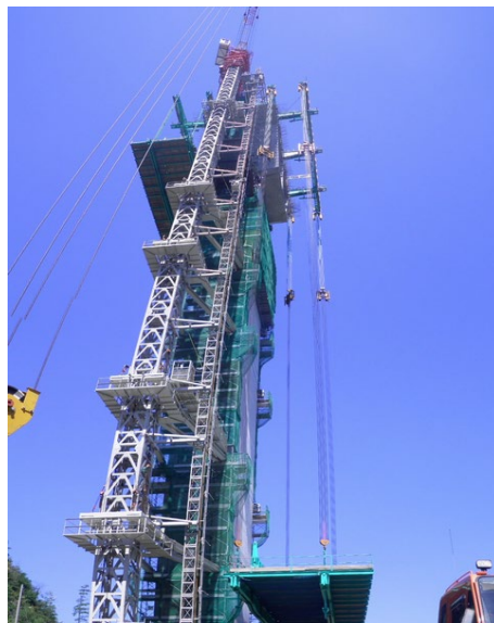
移動作業車の組立
