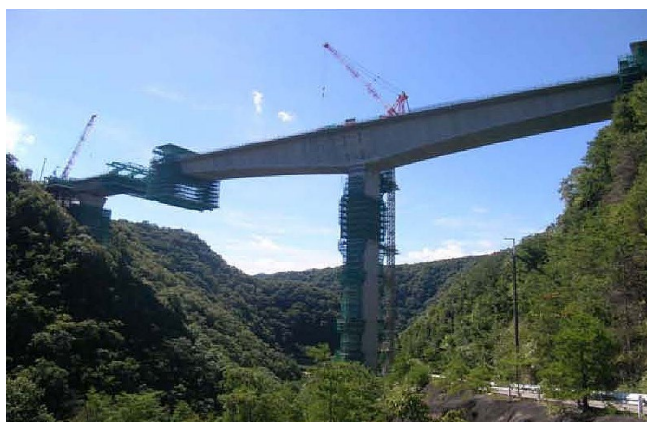
張出し架設の様子
