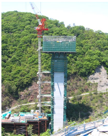
P2柱頭部の施工
