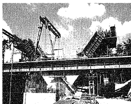
V脚の施工
