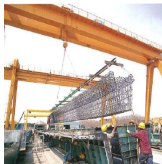
鉄筋を型枠にセット
