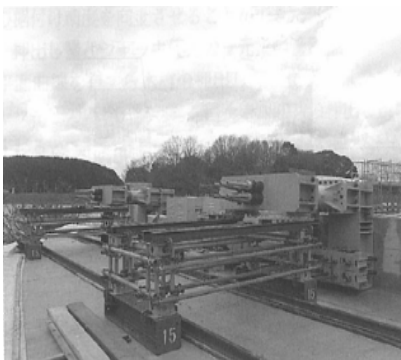
押し出し装置 (反力集中方式)
