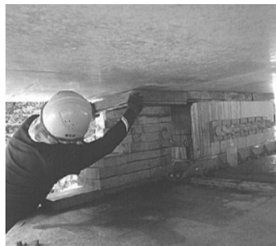
押し出し状況 (すべり支承部)
