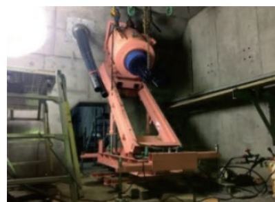
緊張ジャッキの架設
