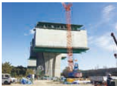
大型ワーゲン(移動作業車)使用
