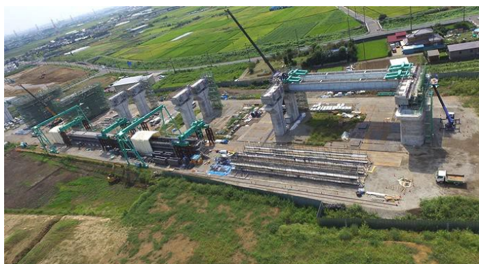
主桁製作ヤードと架設状況
