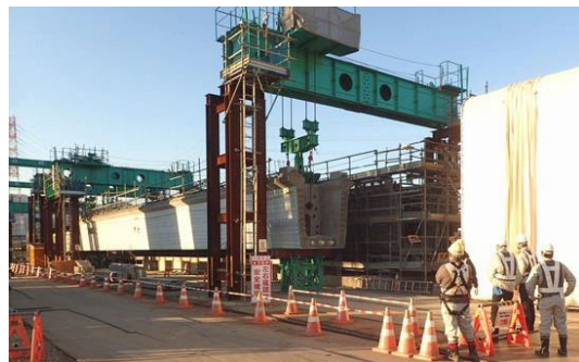
主桁製作設備
