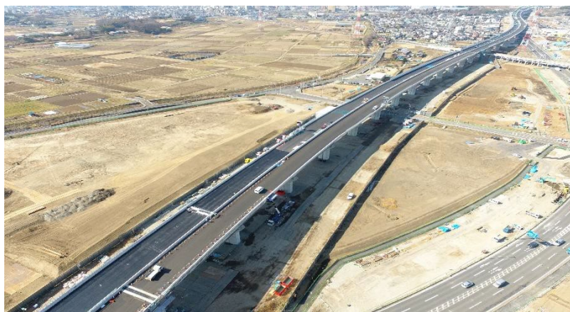
主桁製作ヤードと架設状況
