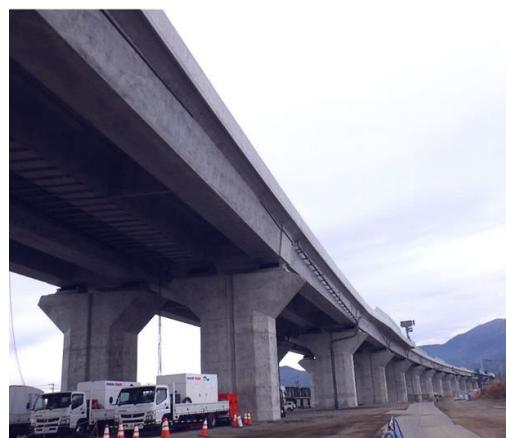
セッティングビームを使用した架設状況
