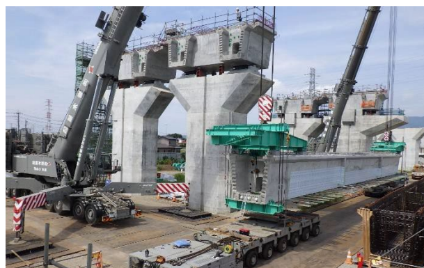
セッティングビームを使用した架設状況
