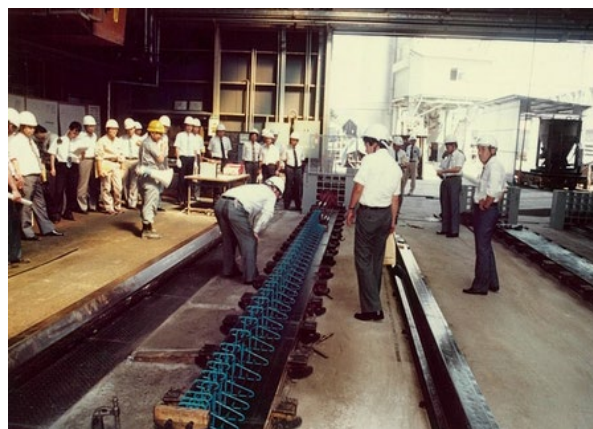
型枠設置前の確認
