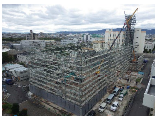
仮設隔離養生
