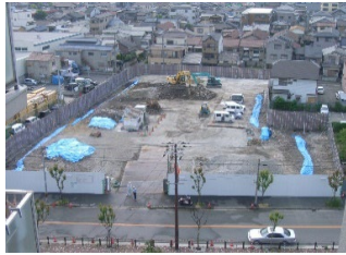
土間基礎解体状況
