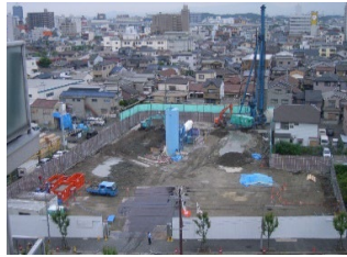
遮水壁設置状況
