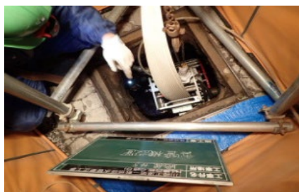
人孔内製管機
