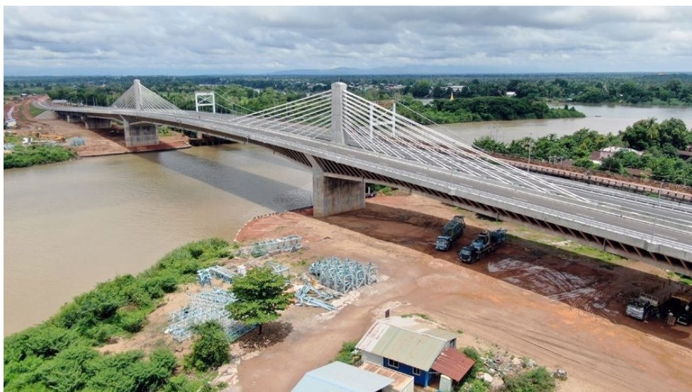
東西経済回廊改良事業(パッケージ 1、ジャイン・コーカレー橋建設事業)
